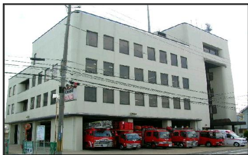
消防局・南消防署併設庁舎
