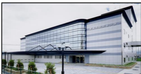
防災センター
