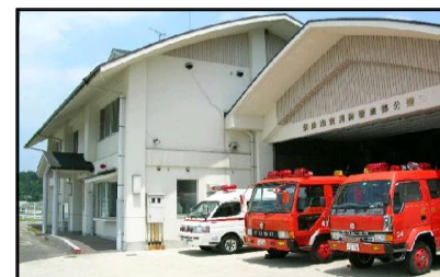
東消防署東部分署
