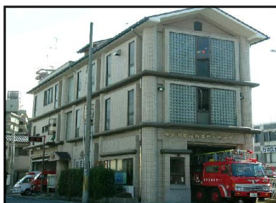
南消防署西大寺分署
