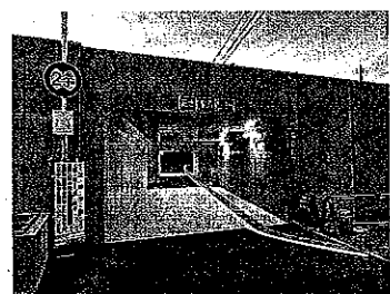
敷島工区と交差し、西大寺赤田町を横断するボックスカルバート
