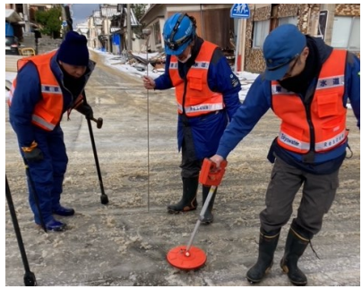
漏水調査 (令和6年能登半島地震)
