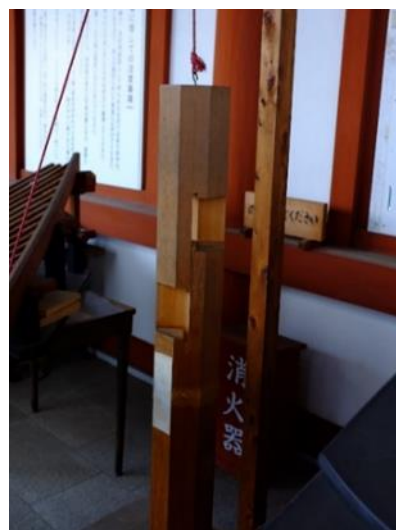
東塔の心柱の模型
