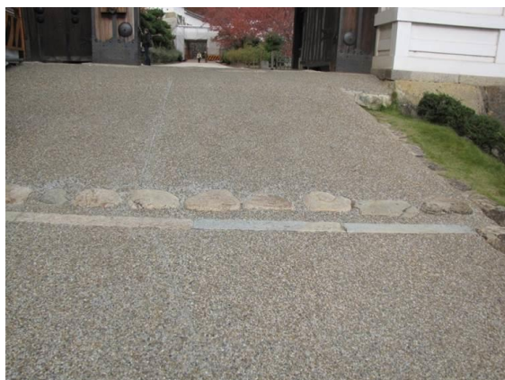
登閣ルート上の路面の補修
