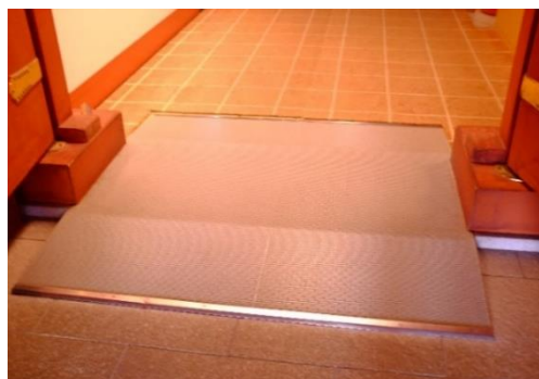
敷居部分に設置されたスロープ
