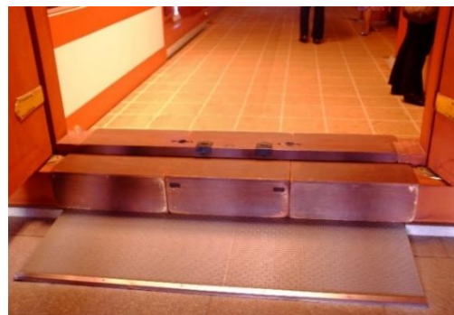
仮設の敷居を設置した状態
