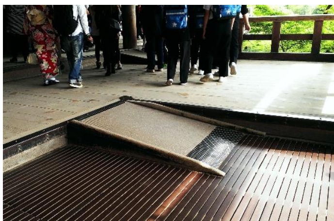
仮設のスロープ
