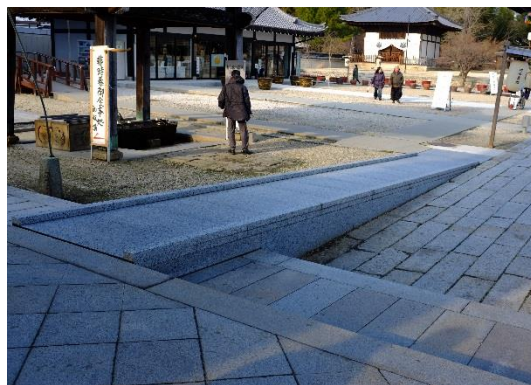
段差部に設置されたスロープ
