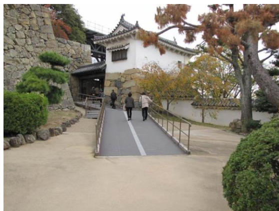
登閣ルート上の段差部へのスロープの設置
