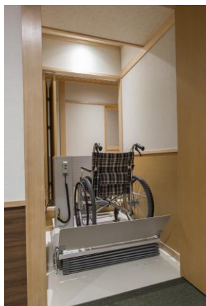
段差解消機の設置
