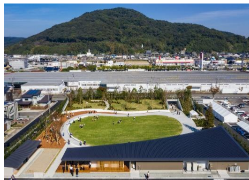
■事例-公有地を活用した広場整備「みんなの公園」 (佐賀県江北町)
