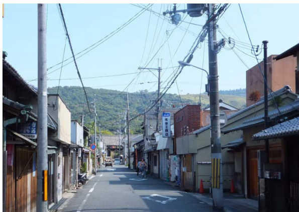
張り巡らされた電線類（一条通）
